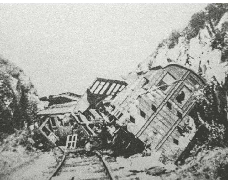
Un train de marchandises déraillé entre Roodt/Syr et Betzdorf. / Ein entgleister Güterzug auf der Strecke zwischen Roodt/Syr und Betzdorf. / A derailed freight train between Roodt-sur-Syr and Betzdorf. MNRDH.
